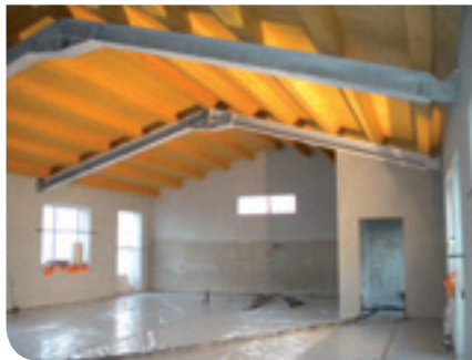
Ampliamento interno - Scuola di Marsan
