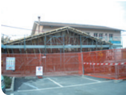
Ampliamento esterno - Scuola di Marsan
