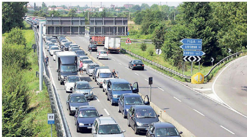
Lavori in corso sulla superstrada all'altezza di Montelupo (foto d'archivio)
