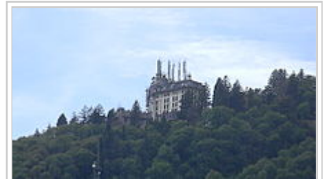
Il fronte posteriore dell'albergo, visto dal Sacro Monte di Varese. Si notano le varie antenne per telecomunicazioni che popolano il tetto e, seminascondo dagli alberi, il portico centrale.
