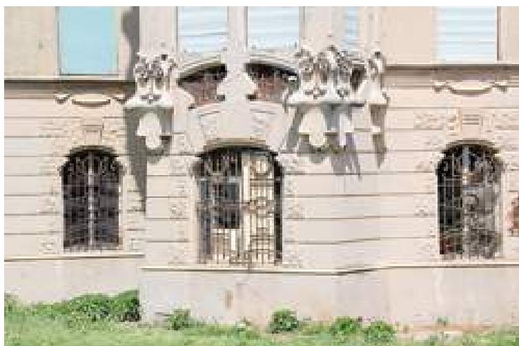
Finestre "murate" con delle assi al pianterreno di Villa Zanelli
